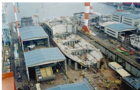
Navire en construction au chantier KAWASAKI - SAKAIDE -
